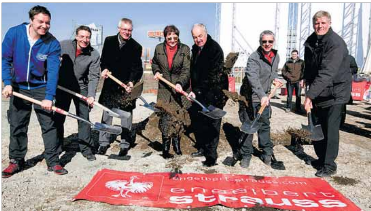
Beim ersten Spatenstich im Gewerbegebiet Talhaus: Das Ehepaar Gerlinde und Norbert Strauss (Mitte) mit von links den Söhnen Henning und Steffen sowie Oberbürgermeister Dieter Gummer, Wirtschaftsförderer Donald Pape und Stadtbaumeister Wilhelm Stulken. Foto: Lenhardt
